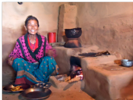
Nouveaux poêle et cheminée réduisant la fumée dans la maison
