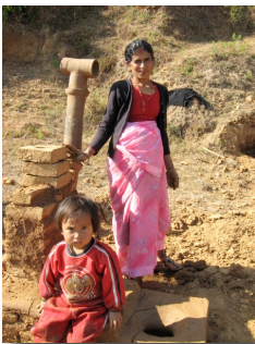
Fabrication des cheminées
